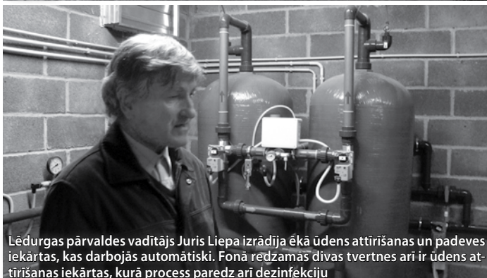
Ūdens attīrīšanas iekārtas uzstādītas nelielajā ēkā blakus lielajam ūdens rezervuāram.
