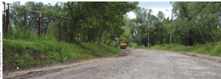
Rāmavas ielas remontdarbu 1. kārta.
