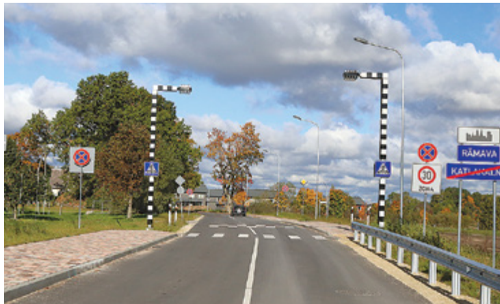
Rāmavas ielas remontdarbu 2. kārta.
