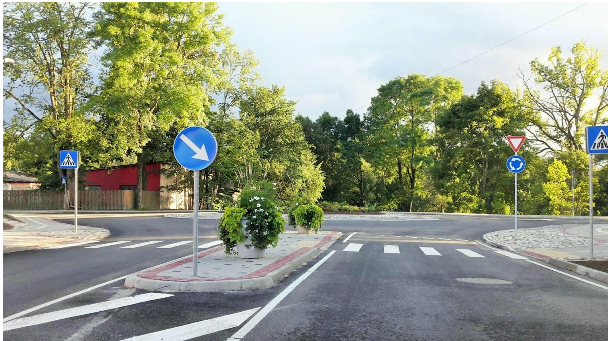
Līdz ar "Cēsis 810" izbūvēts rotācijas aplis Raiņa un Piebalgas ielu krustojumā, kas uzlabo satiksmes drošību un krustojuma caurlaidību.
