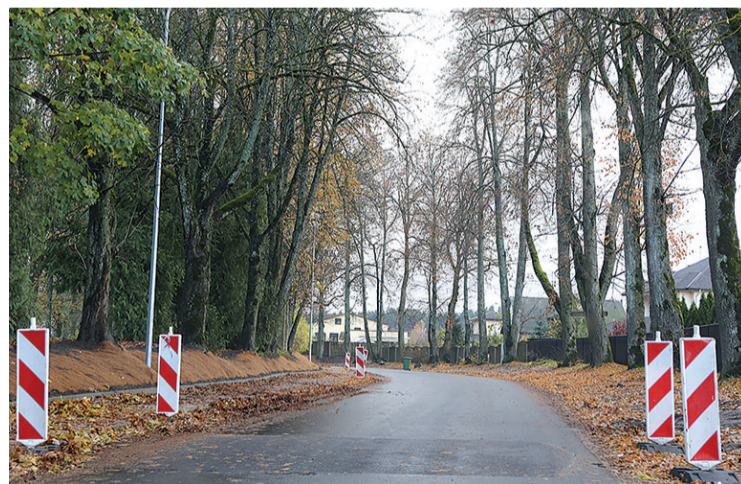
Rāmavas iela pēc 1. kārtas rekonstrukcijas.
