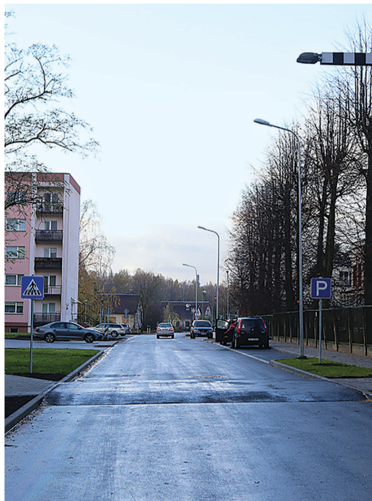
Skolas iela Baložos pēc rekonstrukcijas.
