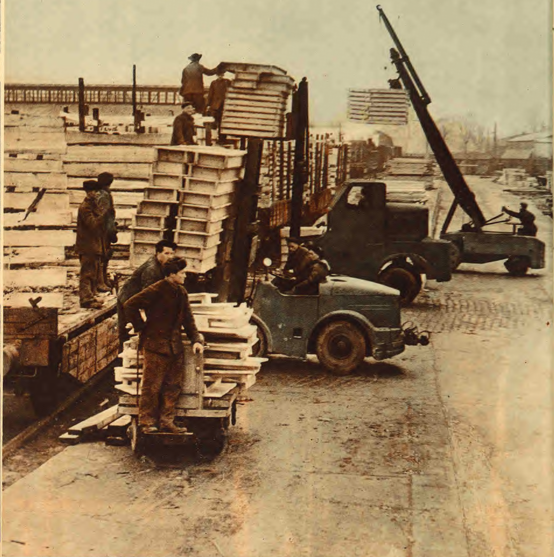
Arvien vairāk tiek mechanizēti darbi mūsu rūpniecās. Attēlā — mechanizētā vagonu iekraušana Rīgas standartmāju rūpniecā.
