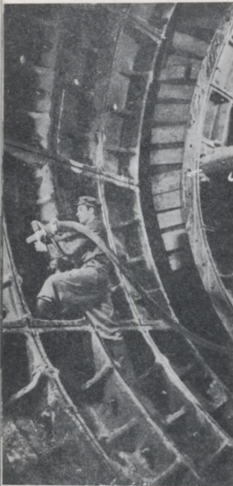
«Suves» starp tubingiem piepilda ar speciālu cementu.
