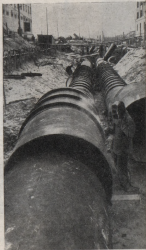
Odenspiegādes cauruļvadu montaža.
