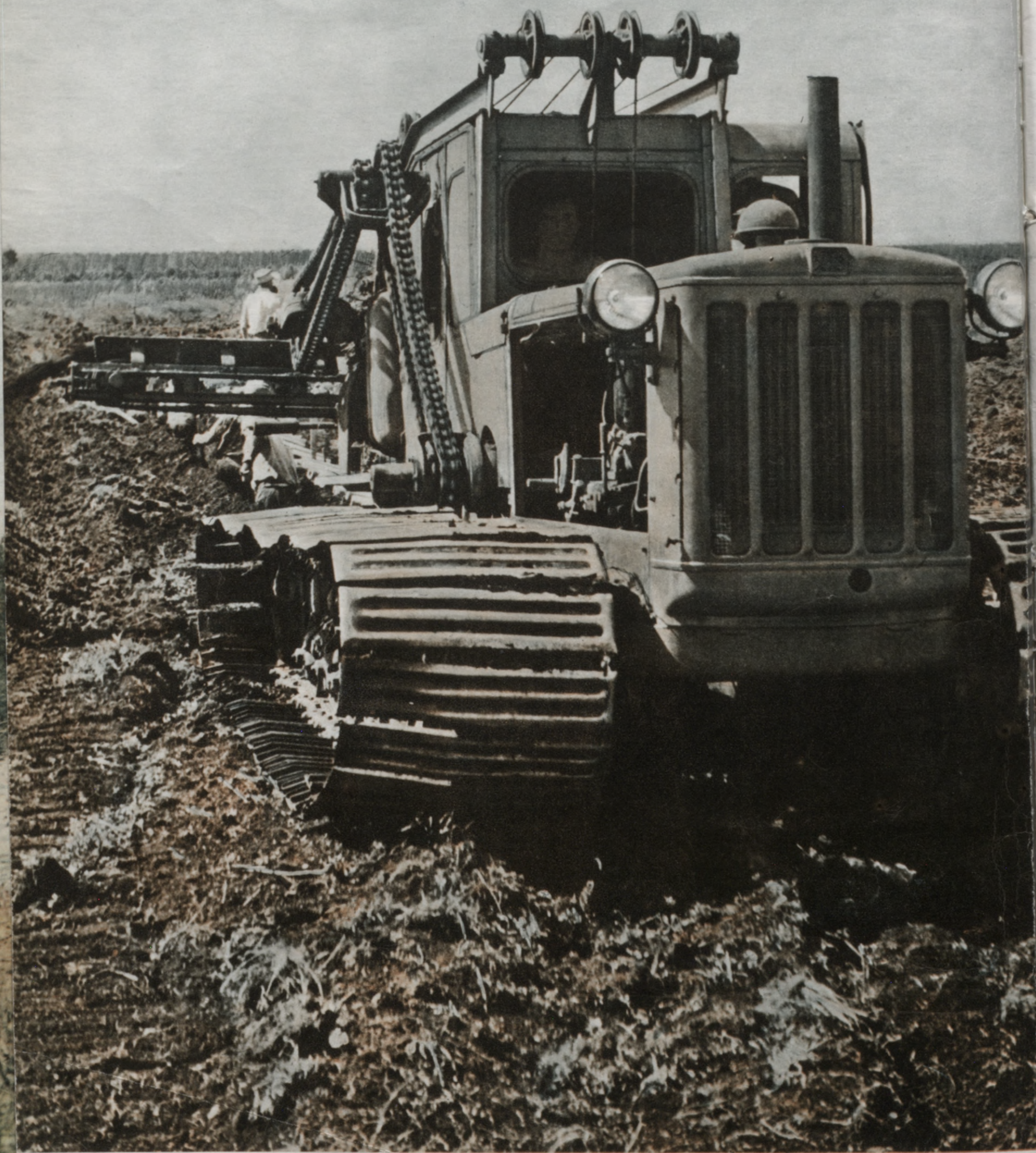
Smiltenes rajona kolchozā «Uzvara» veic meliorācijas darbus ar daudzkausu drenu ekskavatoru ET-141.
