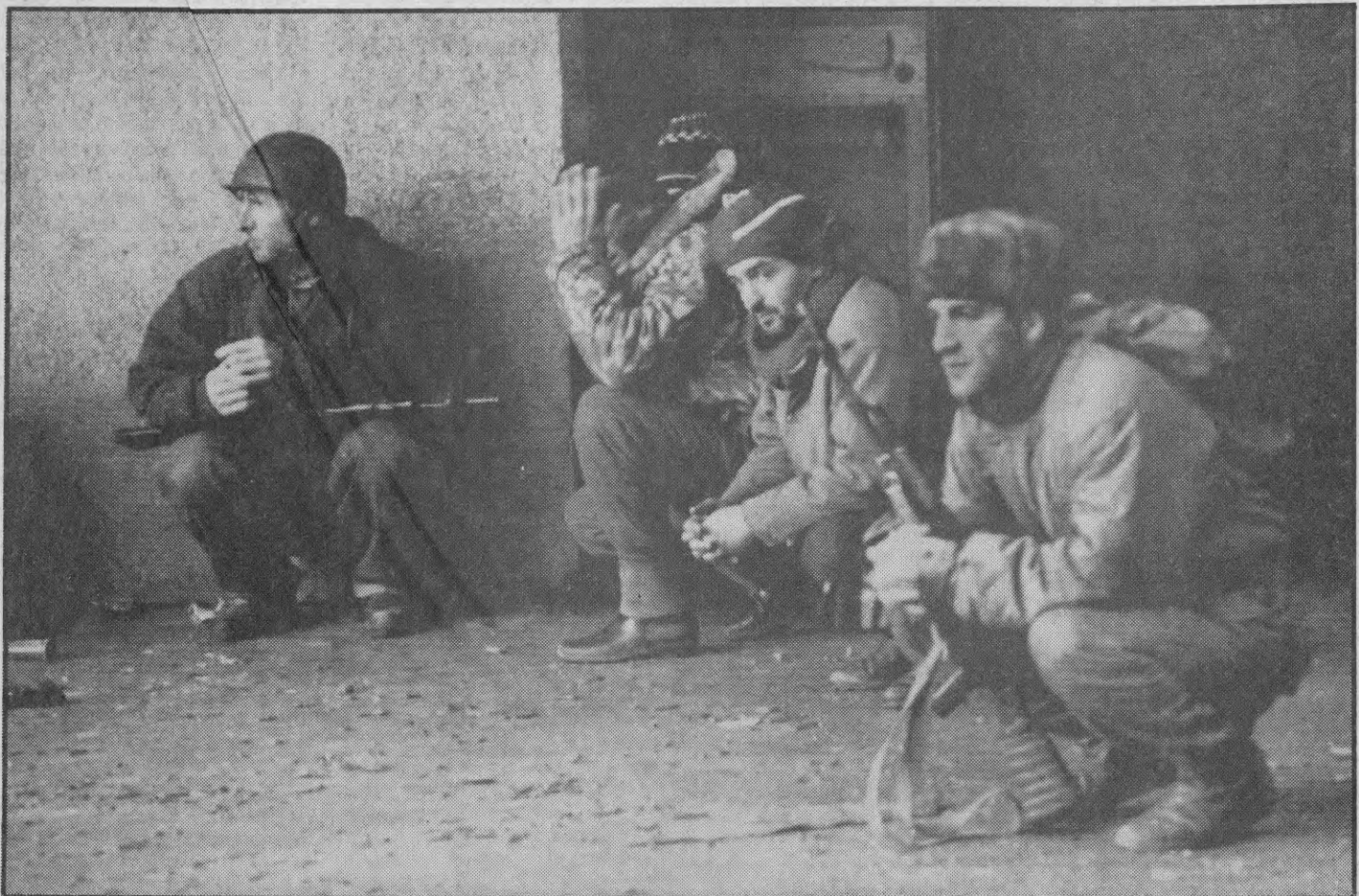
Čečenu brīvprātīgie meklē patvērumu no smagajām apšaudēm pie prezidenta pils. Groznijas centrs ir pilnībā sagrauts. Uz ielām joprojām guļ ap 100 Krievijas karavīru liķi. Foto — EPA—A.F.I.
