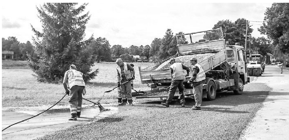
Tranzītielas remontdarbus Limbažu ielā veic VAS Valsts autoceļu uzturētājs
