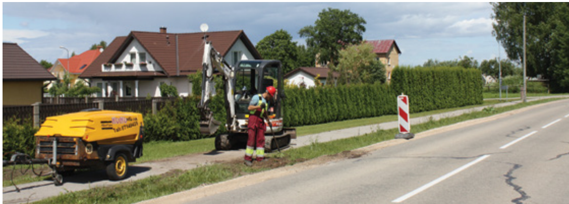
Ielu apgaismojuma izbūves darbi Liepezerā, Babītes pagastā.
